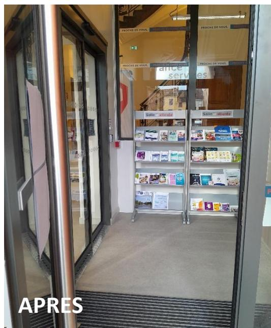
Installation d'une porte automatique pour éviter les déperditions thermiques et pouvoir gérer les flux d'usagers :
