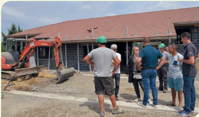
Réunion de chantier avec le maître d'œuvre
